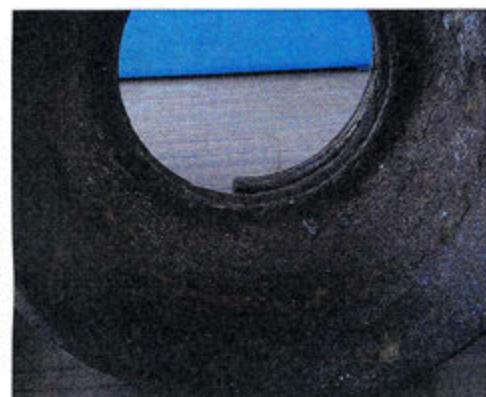
排水管も劣化による赤さび進行がなく黒さび化を確認
