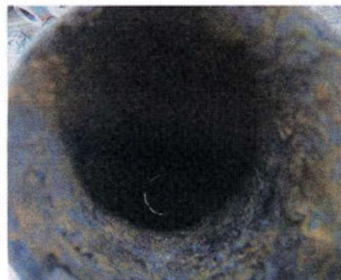
高架水槽2次側給水管。赤さび化は見られず閉塞もなし
